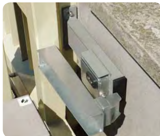
Application sur le «montant anti-basculement» en utilisant la «plaque en T» de fixation du kit.
