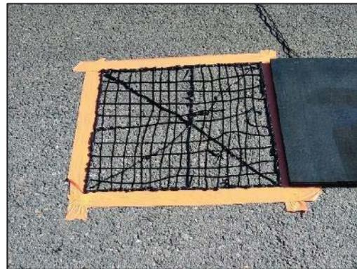
Déposer des rubans de colle en insistant sur la périphérie du tapis-boucle puis positionner celui-ci sur la zone encollée. Retirer le ruban adhésif et réaliser un joint sur le pourtour du tapis en lissant le surplus de colle.
