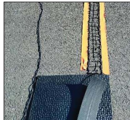
Déposer des rubans de colle en insistant sur la périphérie du passage de câble puis positionner celui-ci sur la zone encollée. Retirer le ruban adhésif et réaliser un joint sur le pourtour du passage de câble en lissant le surplus de colle.
